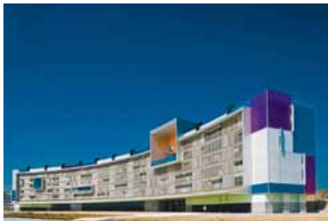
Edificio Hemicycle Solar
